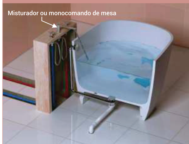
Opção 4: Monocomando de mesa instalado na mureta
