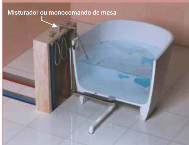
Opção 4: Monocomando de mesa instalado na mureta
